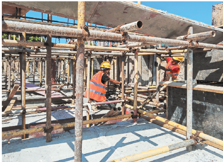
项目施工现场。
