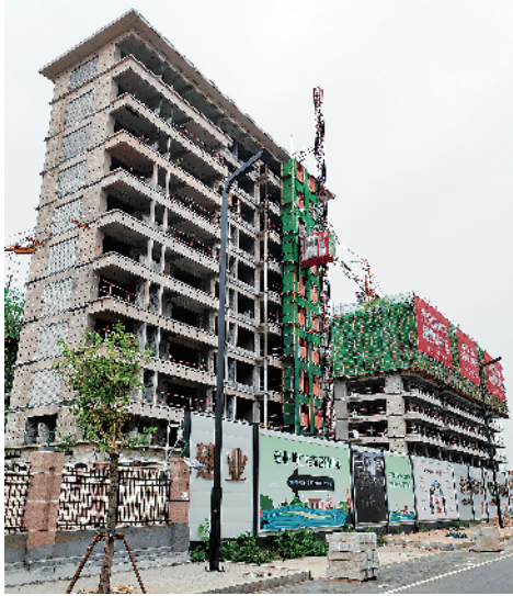
首排2栋洋房主体竣工。
