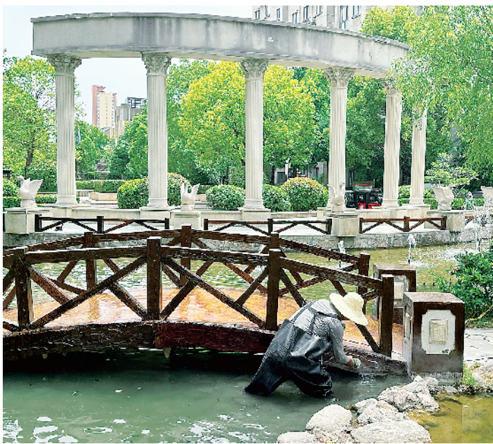
工人翻新景观桥。
