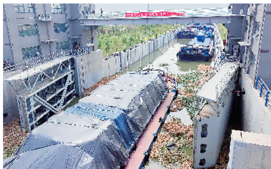
货轮通过沈丘航运枢纽船闸。
